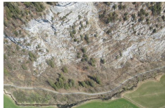
Abbildung 1: Verlauf des Radweges unter Felswänden entlang eines fast 5 km langen Streckenabschnittes.
