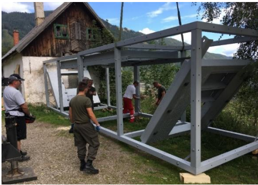
Abbildung 18: USAR Cube Aufbau – angelehnt an Übungsgebäude in Vordernberg (Foto: Aschbacher)
